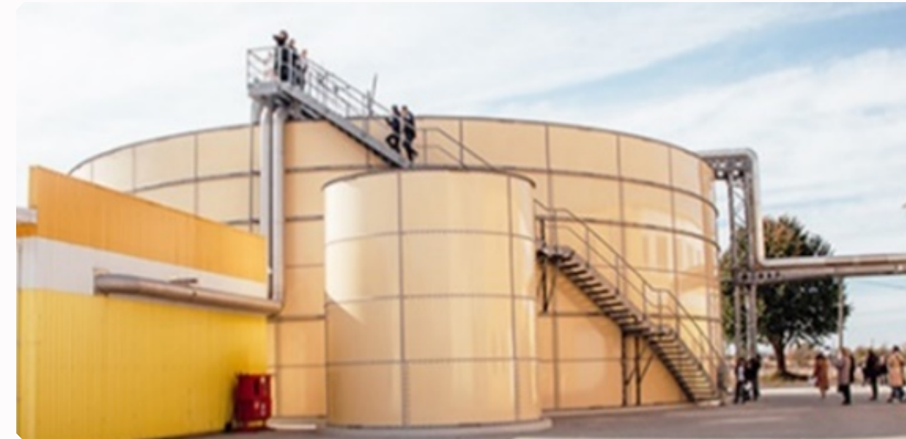
РЕКОНСТРУКЦІЯ ОЧИСНИХ СПОРУД КАНАЛІЗАЦІЇ
