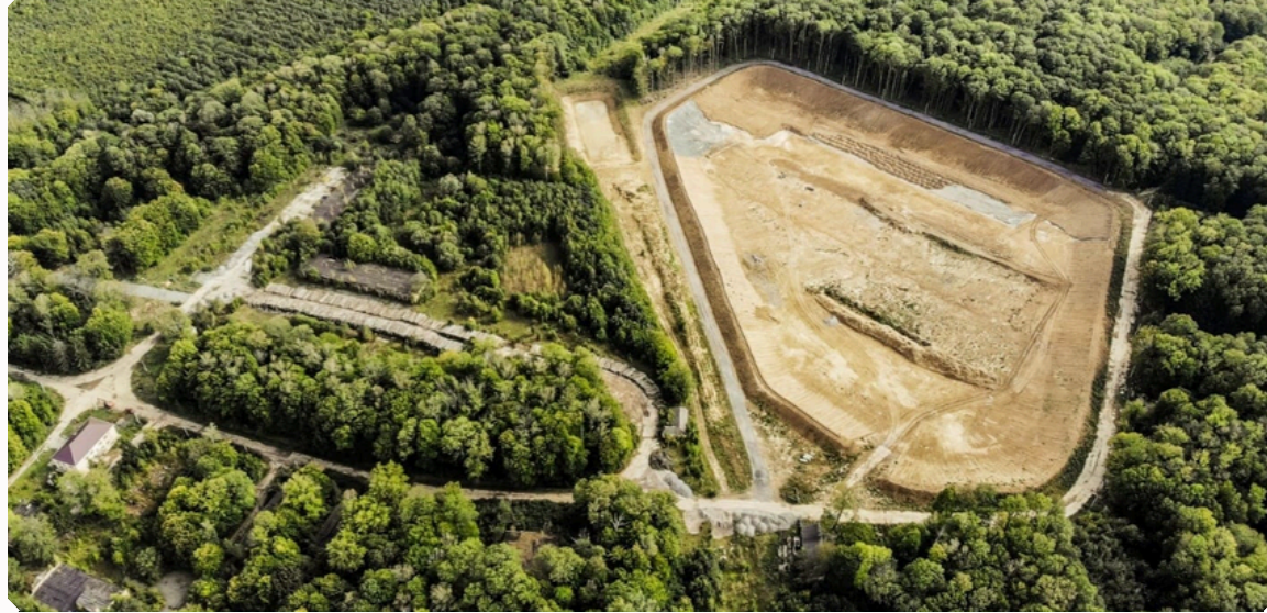
БУДІВНИЦТВО СМІЄСПЕРЕРОБНОГО ЗАВОДУ ТА СТВОРЕННЯ КОМПЛЕКСУ ПО ЗНЕШКОДЖЕННЮ ПОБУТОВИХ ВІДХОДІВ
