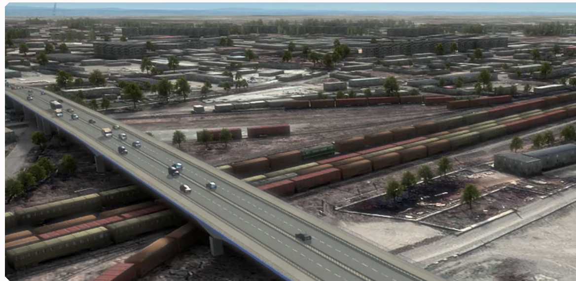
БУДІВНИЦТВО АВТОДОРОЖНЬОГО ШЛЯХОПРОВОДУ ЧЕРЕЗ ЗАЛІЗНИЧНІ КОЛІЇ
